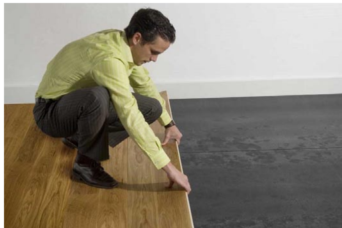
Wahlweise kann der Parkettleger auch vom bereits verlegten Boden aus arbeiten.
