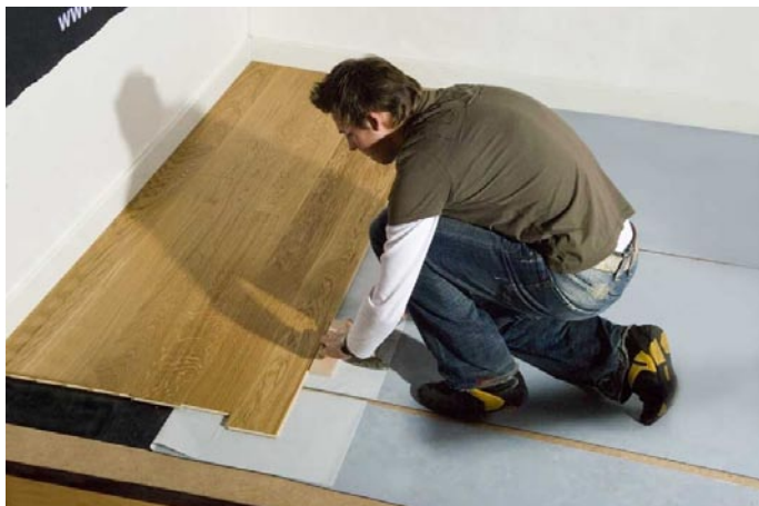
Nachdem zwei Parkettreihen ausgerichtet sind, wird die Schutzfolie unter den Dielenreihen hervorgezogen.
