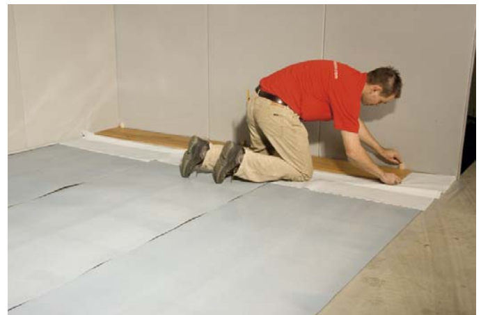
Abstandshalter zwischen Wand und Parkettboden anbringen.
