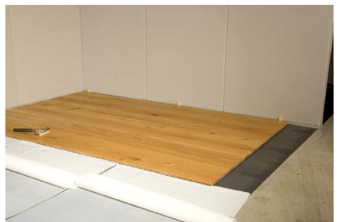
Ab jetzt können mehrere Teile nahtlos verlegt werden, bevor man die Schutzschicht zwischen dem Holz und Elastilon entfernt.
