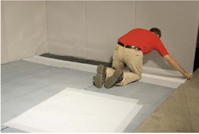
Die Hilfsfolie mit der Faltseite zur Wand sorgfältig auf die freigelegte Klebeschicht auflegen.
