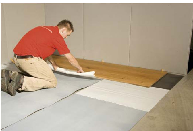
Zweites Parketteil gut schließend (nahtlos) in das erste treiben und anschließend die Hilfsfolie zwischen Elastilon und Parketteil(en) entfernen. Jetzt wird mit der eigentlichen Elastilon-Schutzschicht weitergearbeitet.
