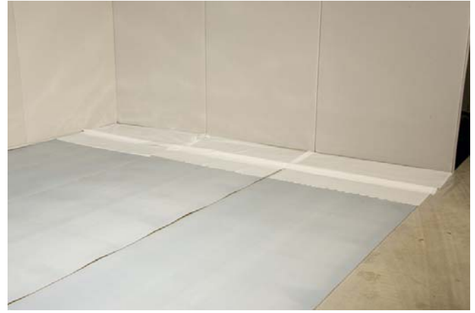
Die Hilfsfolie ist angebracht.
